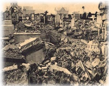
FOTOGRAFIA 9 Cementerio General destruido después de los terremotos
