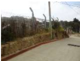
FIGURA 21 Relleno de ripio, fuente: Elaboración propia
