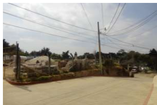
4 FIGURA 47, Alumbrado Eléctrico, Fuente: Elaboración propia
