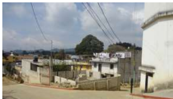
FIGURA 31 Construcciones enfrente del terreno, fuentes: Elaboración propia
