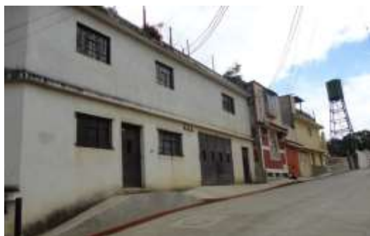
FIGURA 30 Construcciones enfrente del terreno, fuentes: Elaboración propia
