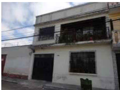
1 FIGURA 67, Ingreso principal, Hogar de ancianos Juan Pablo II, Fuente: Elaboración propia
