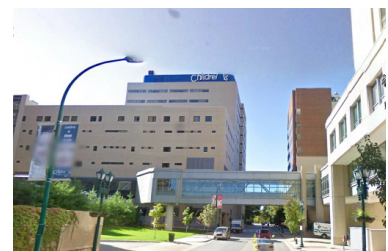
Figura 41. Vista posterior del St. Louis Children Hospital. Fotografía de Google Earth Street View.
