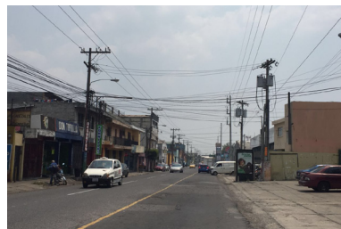
Figura 28. Contaminación visual por tendido eléctrico. Fotografía propia.
