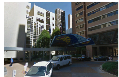
Figura 43. Ingreso principal St. Louis Children Hospital. Fotografía de Google Earth Street View.
