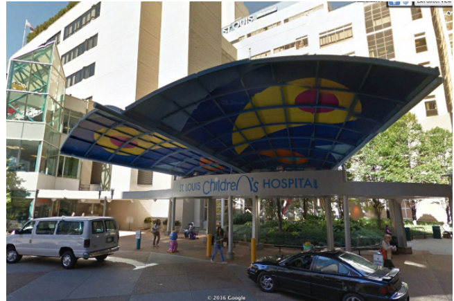
Figura 39. Entrada principal St. Louis Children Hospital. Fotografía de Google Earth Street View.
