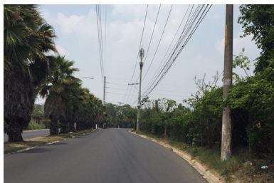
Figura 27. Contaminación visual por tendido eléctrico. Fotografía propia.
