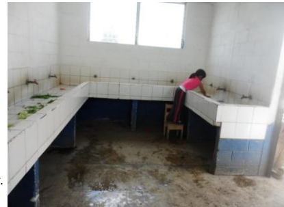
Sector de lavado de verduras. Obtención: Propia
