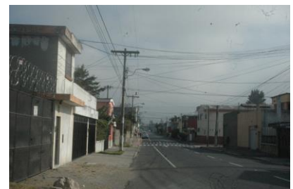
VISTA 3: Vía principal, de un sentido, vista noreste
