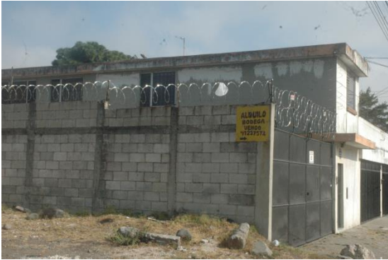
1. Viviendas unifamiliares de uno y dos niveles.
