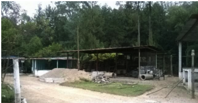
Figura 99 Fábrica de tubos cemento. (Balneario Los Aposentos, Chimaltenango, 2016)
