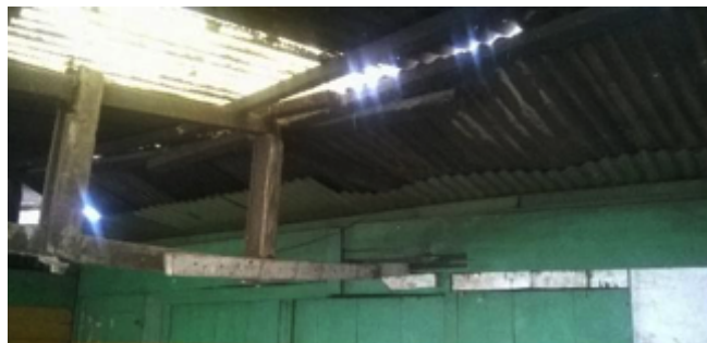
Figura 90 Cubierta artesonado madera. Comedor Balneario Los Aposentos. (Balneario Los Aposentos, Chimaltenango, 2016)
