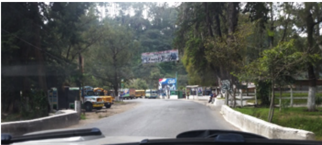
Figura 141 Puente sobre carretera que conduce de Chimaltenango a Los Aposentos. (Balneario Los Aposentos, Chimaltenango, 2016) Nota: Vista en primer plano de el puente sobre el río Guacalate el cual es de dos carriles.
