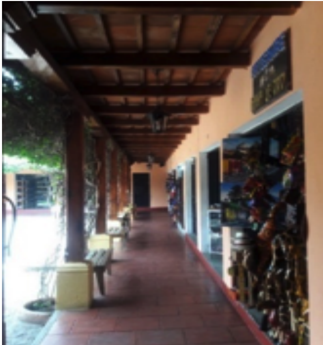
Figura 73 Corredor interno y locales comerciales. (Mercado Artesanías Antigua Guatemala 2,016)
