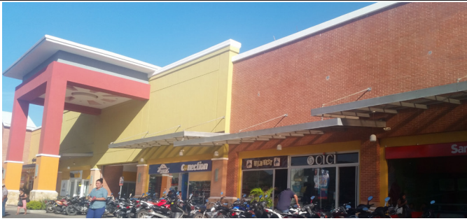
Figura 158 Techos suspendidos por medio de cables en caminamientos frente a locales comerciales. (Centro comercial de Jutiapa, 2016)
