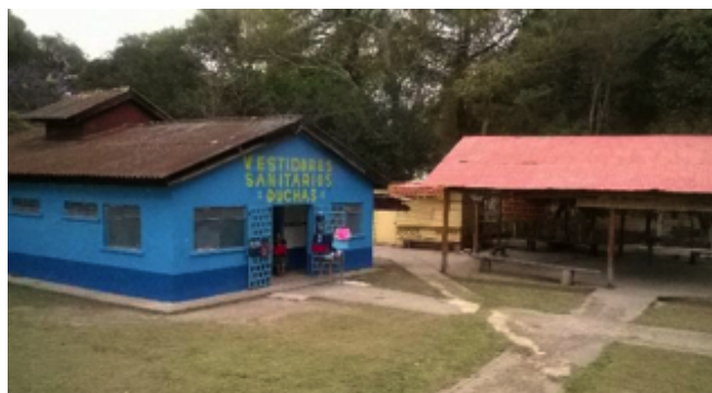
Figura 95 Servicios sanitarios y duchas. (Balneario Los Aposentos, Chimaltenango, 2016)
