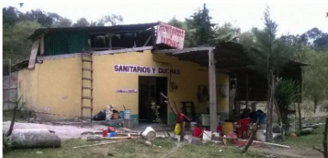
Figura 91 Edificio de Servicio sanitarios públicos, esta en uso y en reparación de su estructura de la cubierta. (Balneario Los Aposentos, Chimaltenango, 2016)
