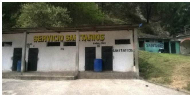
Figura 94 Servicio sanitario y duchas. (Balneario Los Aposentos, Chimaltenango, 2016) Nota: No se cuenta con sistema de tratamiento de aguas servidas.
