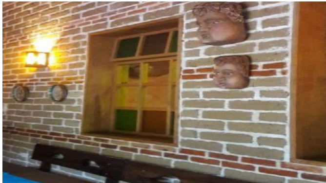
Figura 165 Muro conformado con Adobe y ladrillo de barro. (Hacienda Real, Tecpán, Chimaltenango, 2016)
