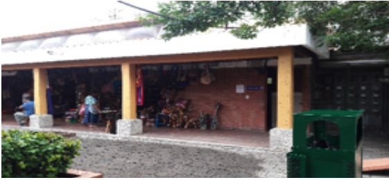
Figura 49 Vista Frontal de la parte mas reciente del edificio. (Mercado de Artesanías Z13, Guatemala 2016)
