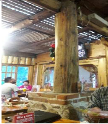
Figura 162 Columna de Madera rolliza sobre base de piedra y ladrillo. (Restaurante Rincón Suizo, Tecpán, Chimaltenango, abril 2016)
