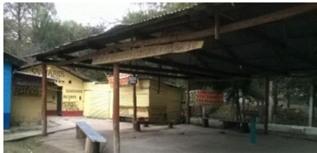
Figura 92 Área para servicio religioso, columnas y vigas de madera rolliza (Balneario Los Aposentos, Chimaltenango, 2016)
