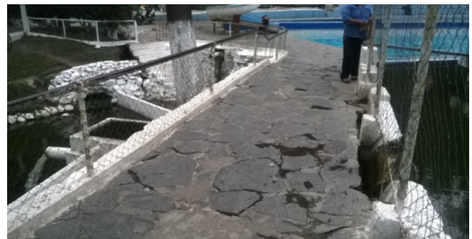
Figura 130 Paso peatonal sobre tubería de rebalse (Balneario Los Aposentos, Chimaltenango, 2016) Nota: Bajo dicho paso se encuentra una caja de registro de concreto en donde queda atrapado los sedimentos.
