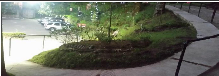
Figura 152 Banqueta de concreto y baranda metálica en caminamientos (Restaurante Rincón Suizo, Tecpán Chimaltenango Marzo 2016)
