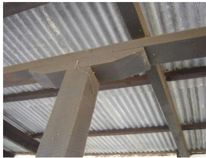
ESTRUCTURA DEL TECHO
