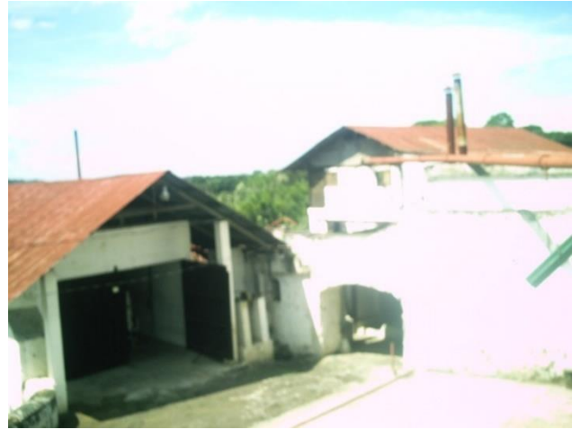
FOTOGRAFÍA 68, CASETA DE PLANTA DE DIÉSEL, Y ATRÁS EL BENEFICIO SECO Foto: Antonio Herrera 2007
