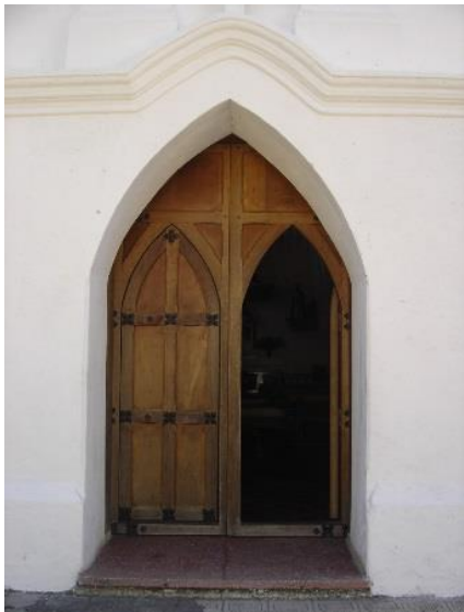
PUERTA DE INGRESO
