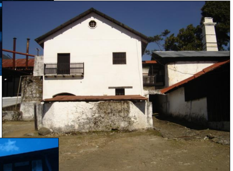
FOTOGRAFÍA 10, TALLER Y PLANTA ELÉCTRICA fuente: Antonio Herrera
