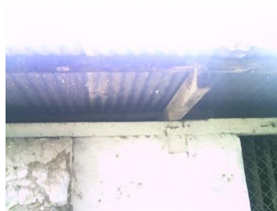
TECHO DE LÁMINA FOTOGRAFÍA 92, ANTIGUA ESCUELA Foto: Antonio Herrera 2007
