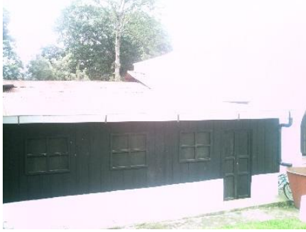
MURO FRONTAL FOTOGRAFÍA 89, ANTIGUA ESCUELA Foto: Antonio Herrera 2007
