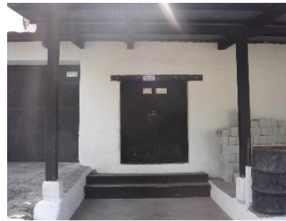
PUERTA DE INGRESO
