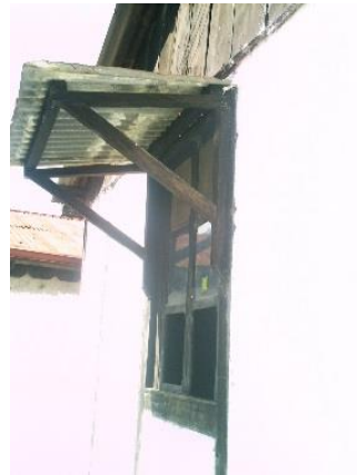
DETALLE DE VENTANA FOTOGRAFÍA 117, GUARDIANÍAS Foto: Antonio Herrera 2007
