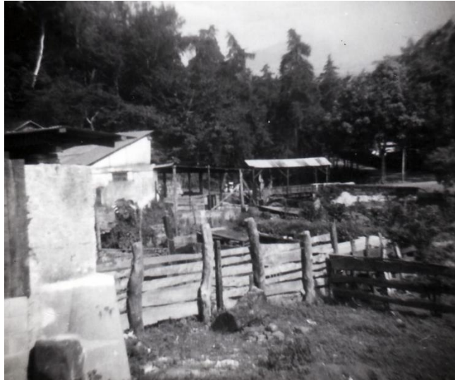
FOTOGRAFÍA 62, PANORÁMICA, AL FONDO PUENTE DE INGRESO Foto: Cesar Augusto Cabrera 1960
