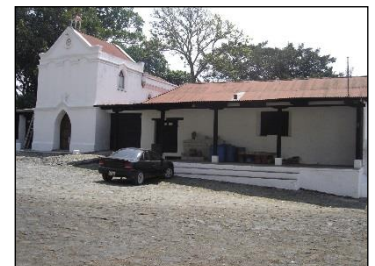
FOTOGRAFÍA 78, BODEGAS DE PLAGUICIDAS Y ABONOS Foto: Antonio Herrera 2007
