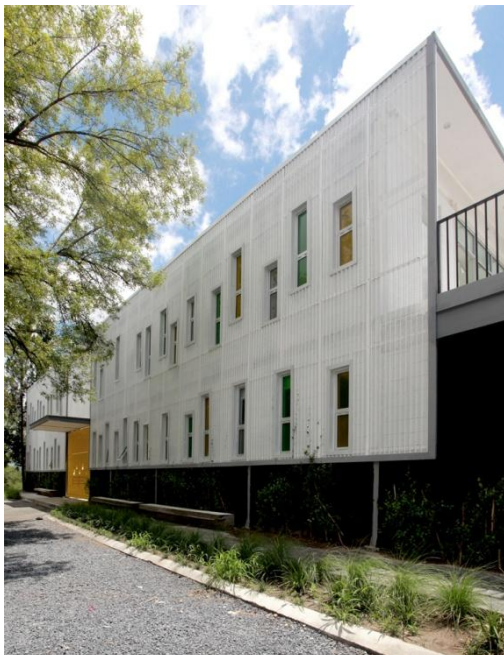
Fotografía 13. Vista de la fachada frontal, construida con elementos metálicos Fuente: Ana Cecilia Garza Villarreal
