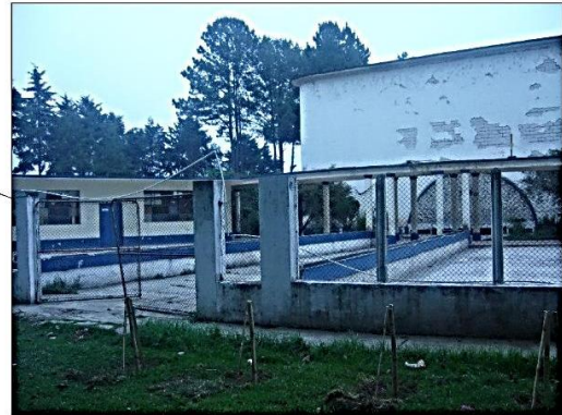
VISTA DE LA SALIDA POSTERIOR DE LA ESCUELA TIPO FEDERACION "ULISES ROJAS", QUE SERA EL INGRESO PRINCIPAL DEL PROYECTO. FUENTE: ELABORACION PROPIA
