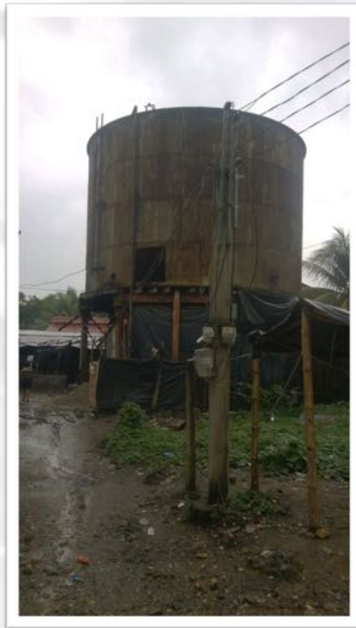
5 Tanque de Agua elevado del otro lado de la calle frente al terreno
