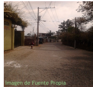
CALLE DE ACCESO DE ADOQUIN SIN CAMINAMIENTO PARA PEATONES, INFRAESTRUCTURA EXISTENTE.
