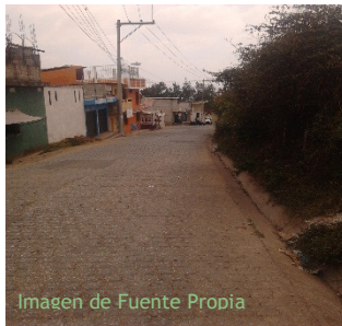
CALLE DE ACCESO DE ADOQUIN SIN CAMINAMIENTO PARA PEATONES
