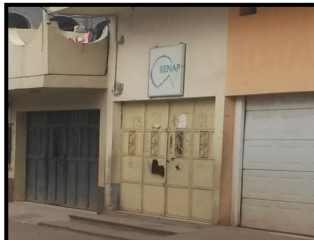
FOTOGRAFÍA N.4: Gilberto Torres 17-09-2014 Centro de Registro de Ciudadanos –RENAP–, ubicación barrio La Federal, casco urbano, municipio de Asunción Mita, Jutiapa.
