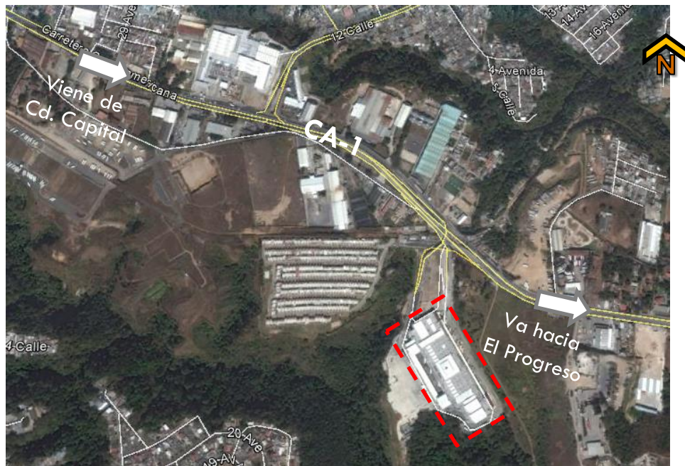
Imagen 7: Vista Aérea de Central de Transferencia Norte Fuente: Google Earth
