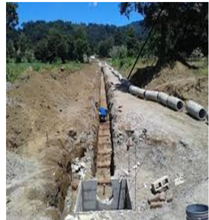
Figura 5.10: Sistema de drenajes en construcción, Santa María Cauque. www.google.com , 2015.
