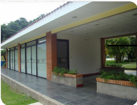
IMAGEN NO. 8 EDIFICIO PRINCIPAL
