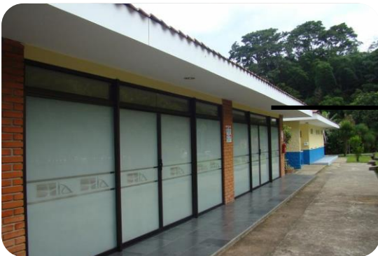
IMAGEN NO. 7 EDIFICIO PRINCIPAL
