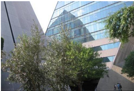
Imágenes 2.3.3.11 vista terrestre del Servillettero. Obtenidas a partir de imágenes google earth
