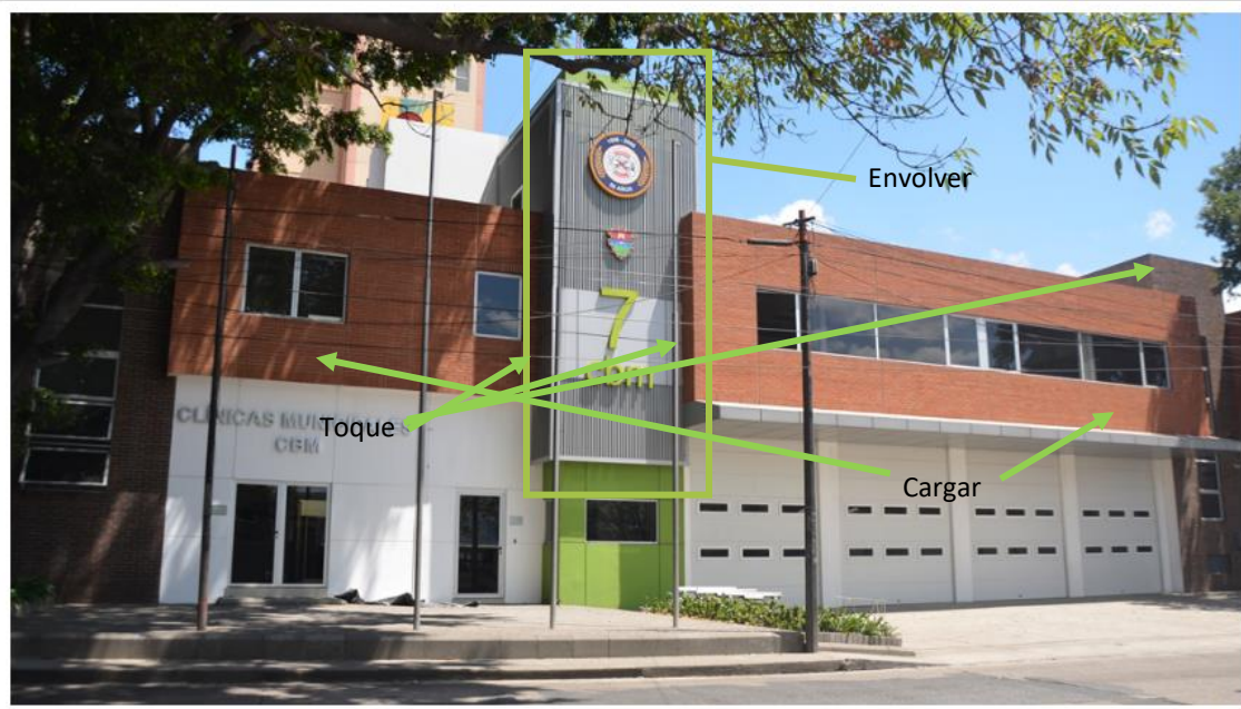
Imagen 2.2.2. Estación No. 7 de Bomberos Municipales.
