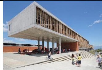
Imagen 6.2.20 Ejemplo de uso de materiales nobles. imagen recuperada 18/05/2015 de http://img1.adsttc.com/media/images/50ce/1931/b3fc/4b70/6200/0539/large_jpg/IMG_3575.jpg?1361400807
