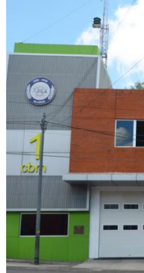
Imagen 6.2.14 Ducto de escalera de Estación de Bomberos. imagen recuperada : http://www.bomberosmunicipales.org.gt
