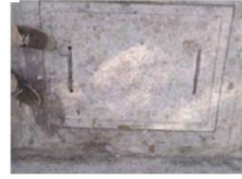
ACOMETIDA AGUA POTABLE
