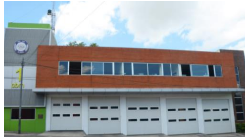
Imagen 6.2. 15 Fachada de Estación de Bomberos. imagen recuperada : http://www.bomberosmunicipales.org.gt
