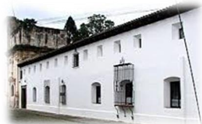
Imagen 3. Hospital de La Antigua Guatemala
