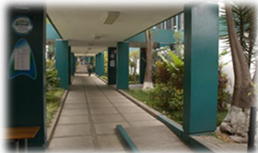
Imagen 27. Pasillos de Techados, INTECAP Guatemala 1
