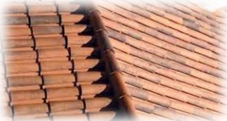
Imagen 15. Vista de Cubierta de teja
