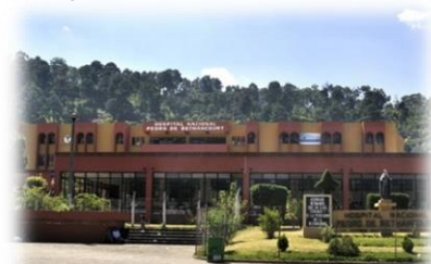
Imagen 4. Hospital de La Antigua Guatemala
