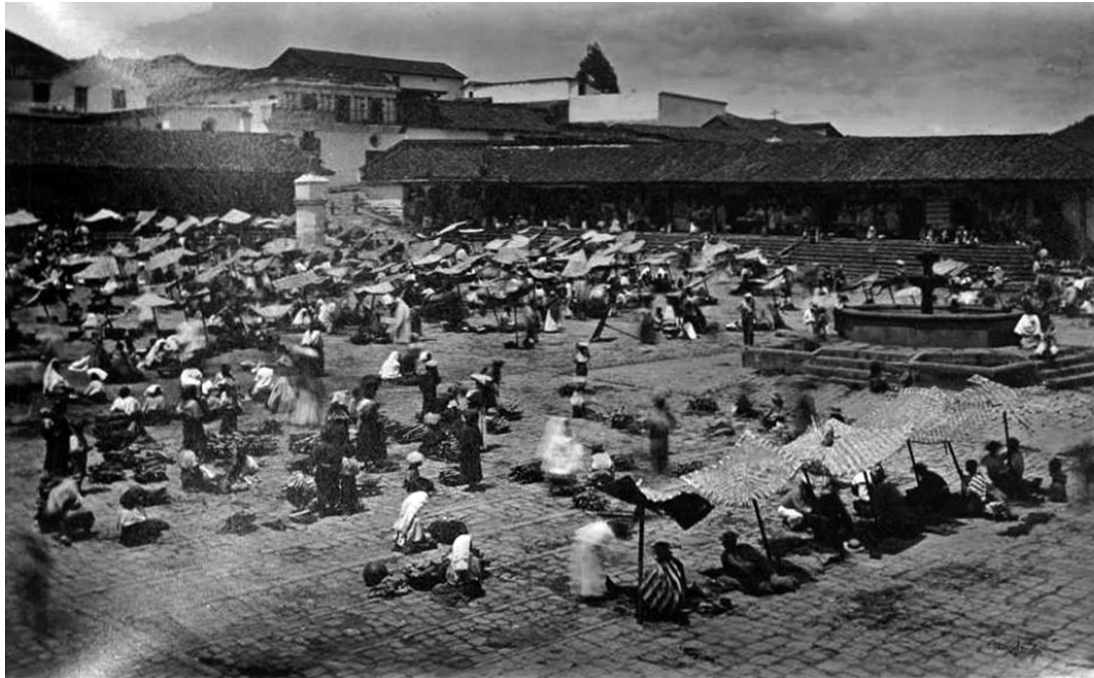
Figura 6-11. Plaza de Quetzaltenango. Fotografía de E. Muybridge, 1875. Fuente: Proyecto de Revitalización.
