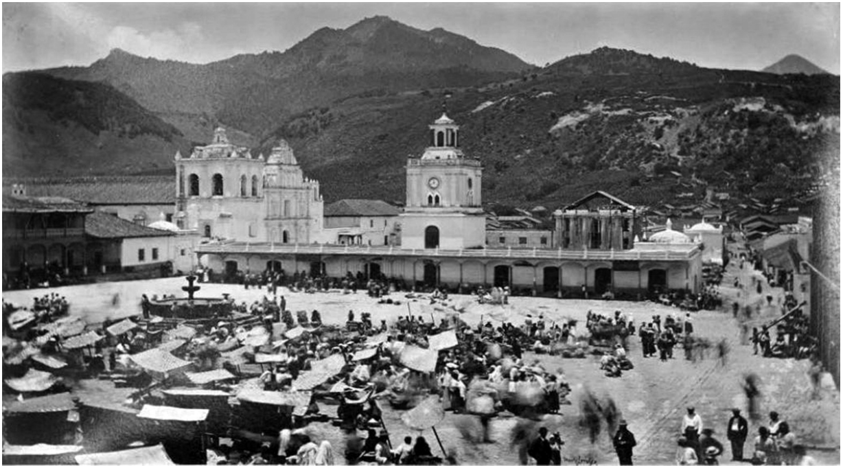
Figura 6-12. Plaza de Quetzaltenango. Fotografía de E. Muybridge. Fuente: Proyecto de Revitalización.
