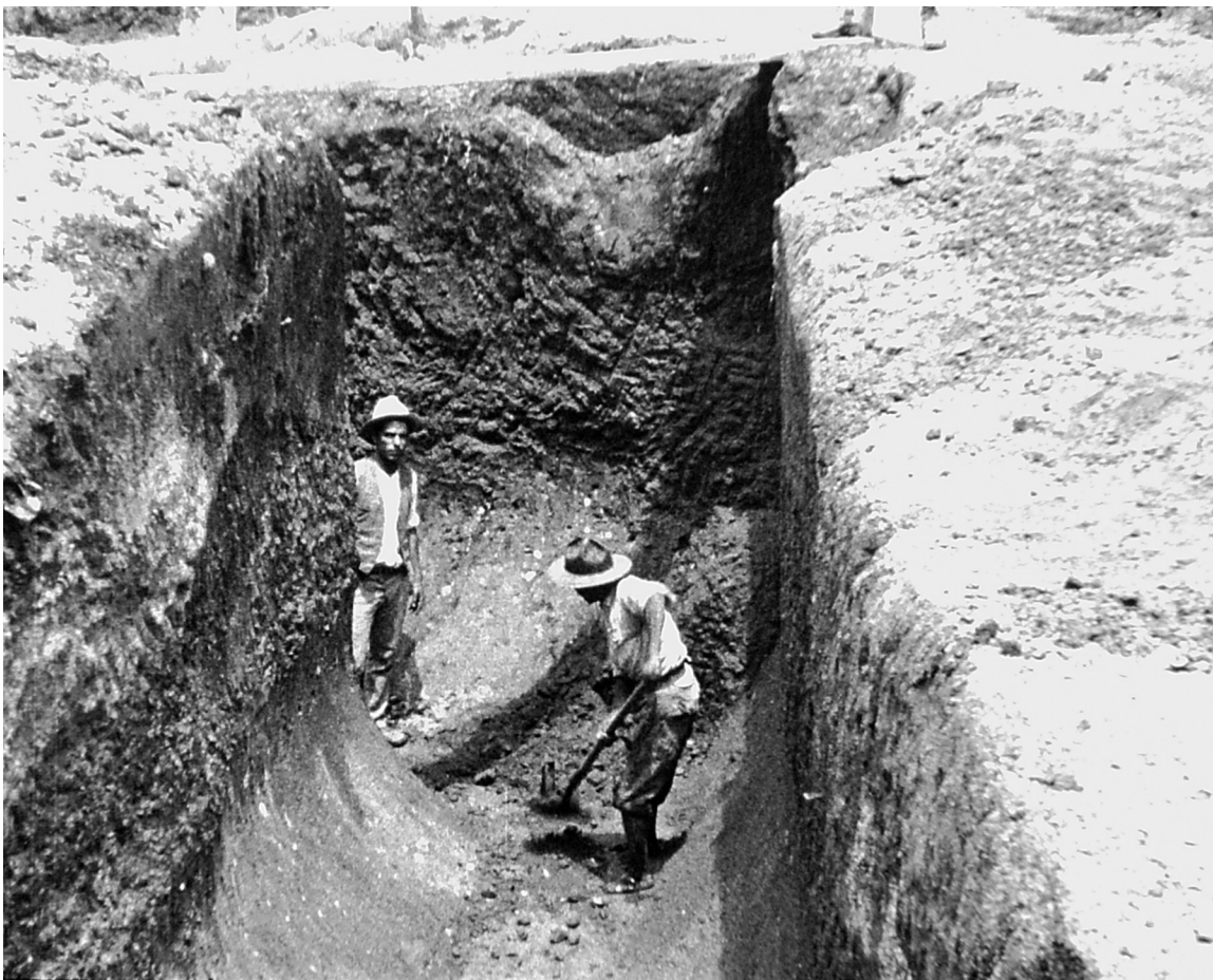
Figura 2-29. Trabajos de saneamiento en el Guardia Viejo. Película de la Tipografía Nacional, de 1930. Digitalización: E. B-
