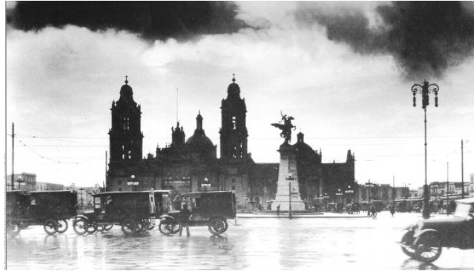
Figura 4-36. El Zócalo, Ciudad de México, en 1920. La plaza luce despejada de árboles y jardines. En cada esquina se construyó un Pegaso, “para hermostear” el lugar. Arqueología mexicana , 66.
