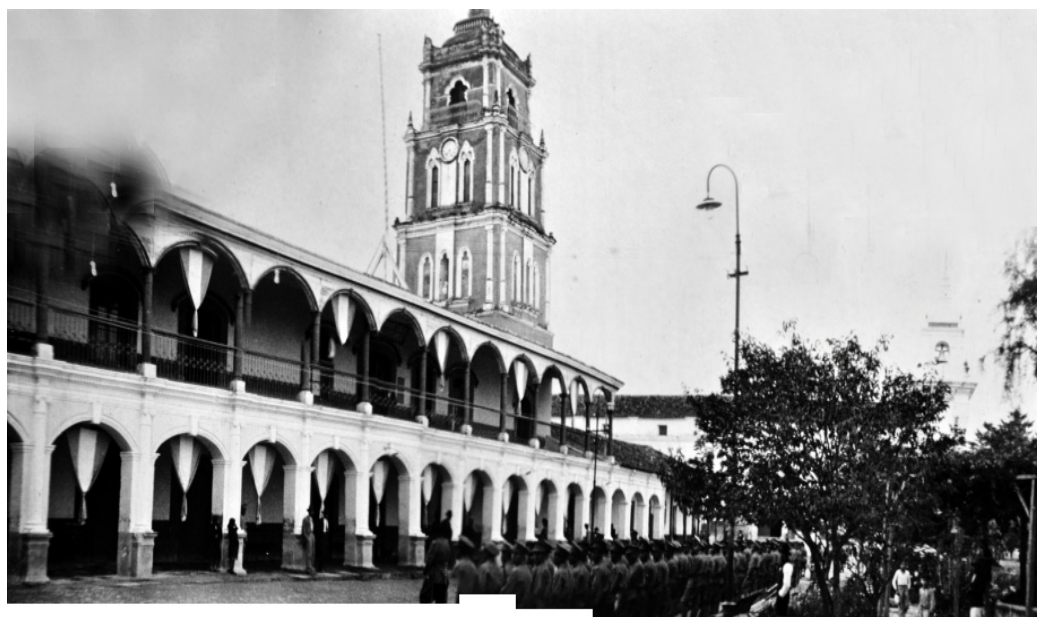
Figura 6-22. Panorámica del edificio de Gobernación de Huehuetenango. Gira presidencial de 1934. Digitalización y elaboración: E. B.
