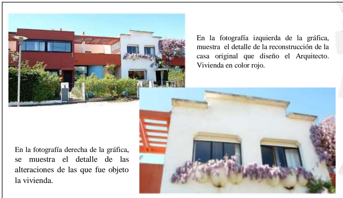
Figura 15 Alteraciones de la Casa Lesage de Pessac de Le Corbusier
