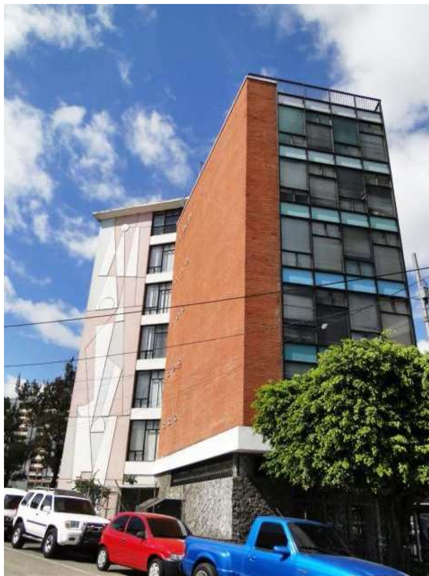
Figura 163. Uso de materiales en fachada sur de edificio Italia. Nota: En la fotografía puede apreciarse la concentración de los materiales aplicados por Pelayo Llarena Murua, generando contrastes de lo moderno con lo tradicional, por el uso del acero, el vidrio versus la piedra y el ladrillo de barro cocido.
