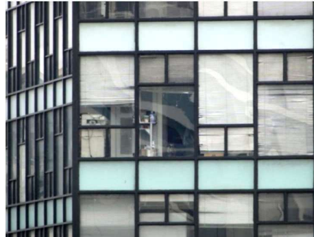
Figura 158. Detalle de Muro cortina en edificio Italia
