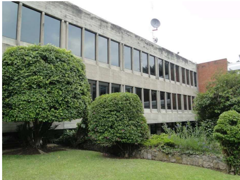
Figura 198. Edificio de producción, actual Agencias J. I. Cohen (Anteriormente Laboratorios Abbott).
