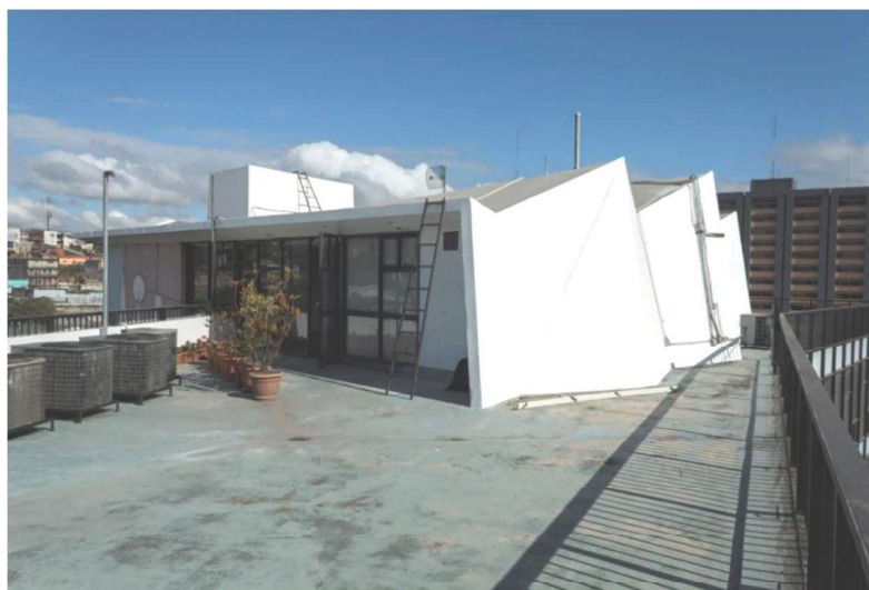
Figura 154. Adición y remate en edificio Italia
