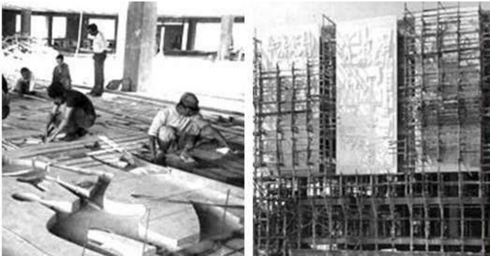
Figura 11. Ejecución de formaletas de los relieves del Crédito Hipotecario Nacional, diseñados por Efraín Recinos y Roberto González Goyri.
