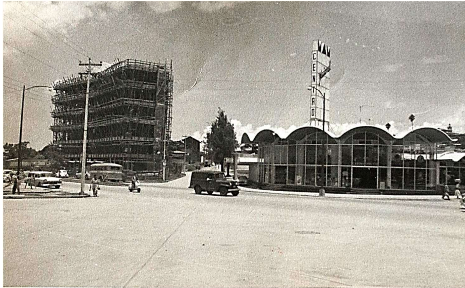
Figura 125. Edificio Italia en construcción y contexto artificial construido.
