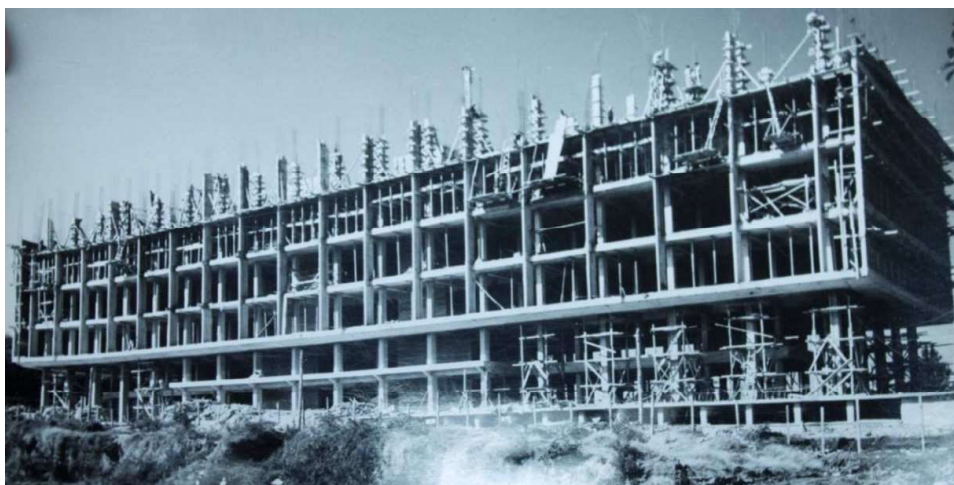
Figura 118. Palacio Municipal en construcción, Ciudad de Guatemala, 1954. Fuente: Reproducción por AAQ, del archivo de Pelayo Llarena, 2015.
