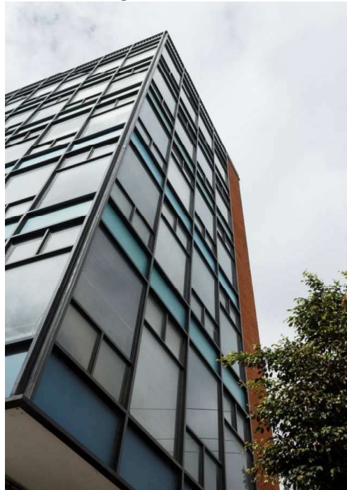
Figura 159. Muro cortina en fachada Norte, edificio Italia.
