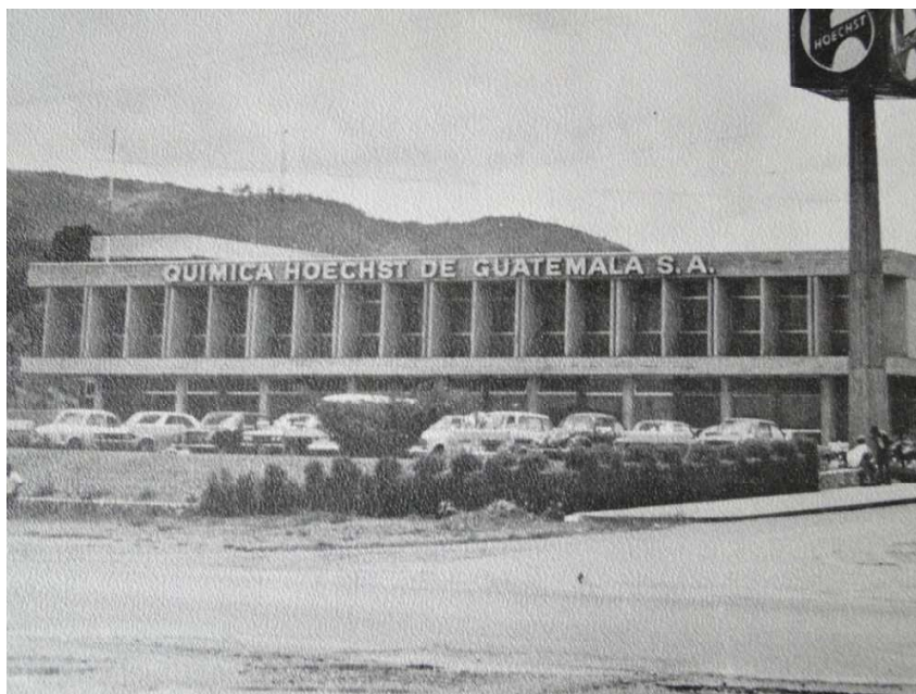
Figura 207. Química Hoechst en Calzada Roosevelt, Ciudad de Guatemala. Fuente: Reproducción de archivo de Max Holzheu.
