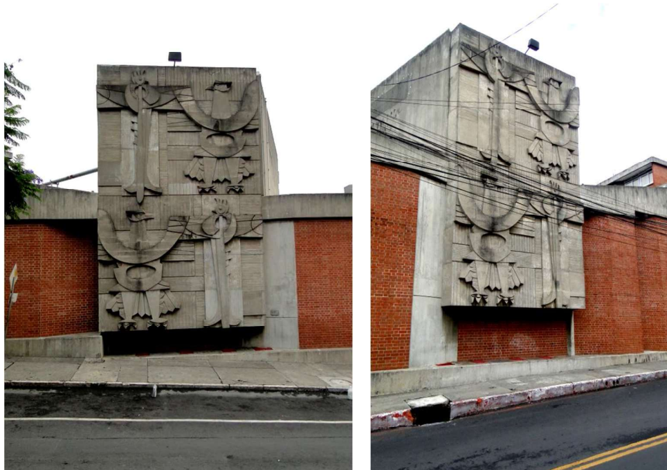
Figura 35.1. Edificio del Instituto Guatemalteco Americano desde esquina de Ruta 1 y 9a. Avenida, Zona 4 de la ciudad de Guatemala y relieves en fachadas hacia ambas vías. Fuente: Fotografías de JMLP, 2016.
