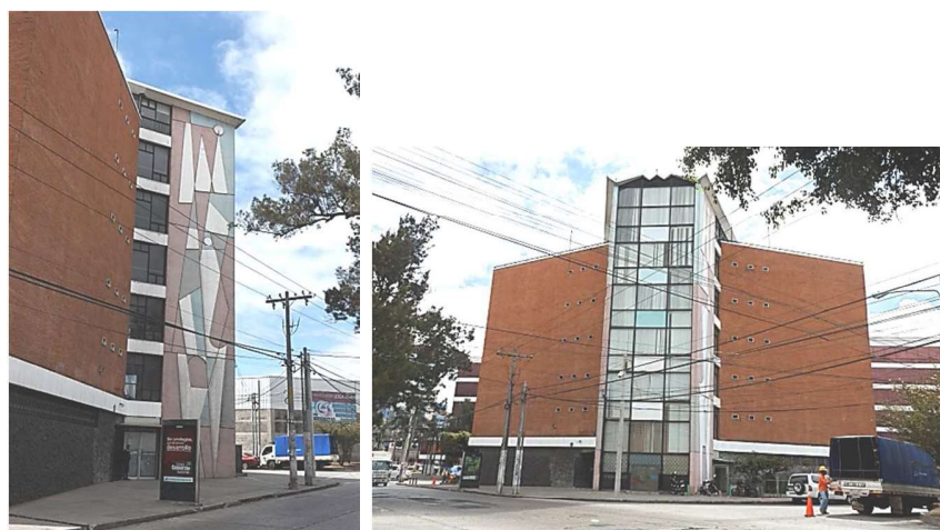
Figura 182. Vistas de edificio Italia, desde Vía 1 y Ruta 3 zona 4.
