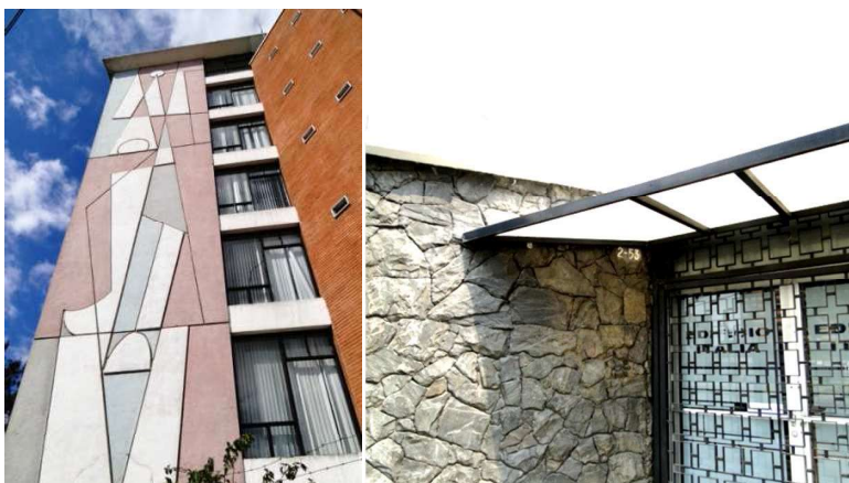
Figura 2. Mural de Carlos Mérida en fachada sur de Edificio Italia y detalle del ingreso lateral norte. Fuente: Fotografías de Jorge Mario López Pérez, 2014.
