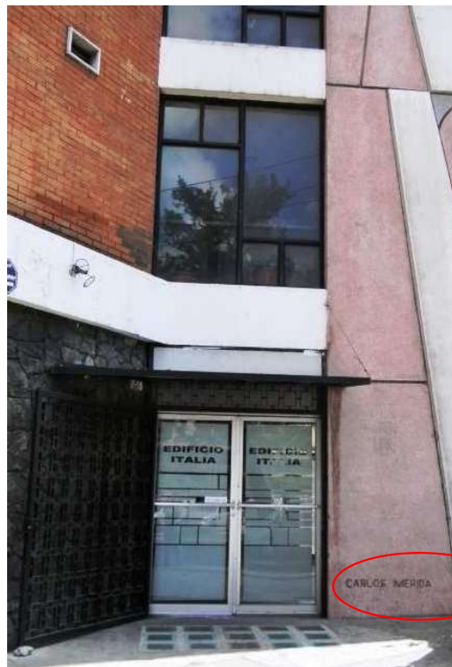
Figura 169. Ingreso principal actual al edificio Italia.
