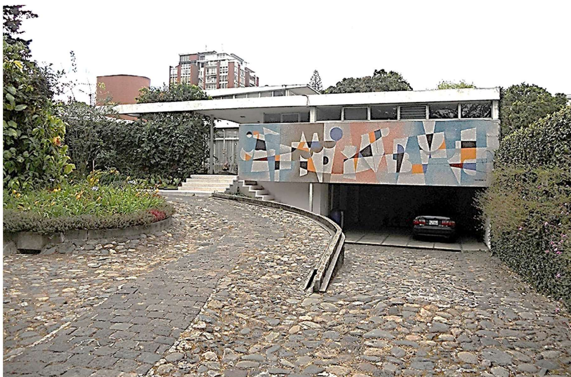
Figura 17. Mural de Carlos Mérida en muro sobre garaje, fachada Noreste en Vivienda de Rafael Picciotto. Nota: La fotografía muestra un empedrado en la circulación vehicular al ingreso de la vivienda que connota la localidad. En el fondo uno de los edificios que se ubican en el sector, donde continúa la construcción de este tipo de arquitectura inmobiliaria en amenaza del cambio de uso donde había viviendas unifamiliares de la clase alta.
