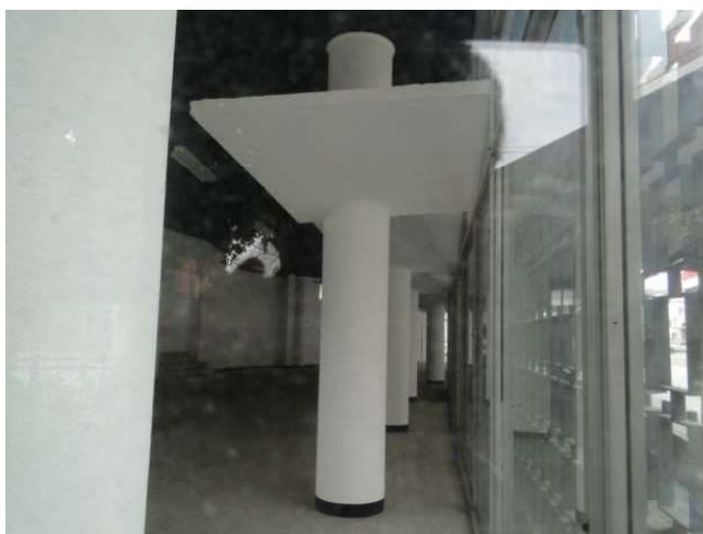
Figura 149. Columnas cilíndricas que penetran la losa plegada en voladizo de edificio Italia.
