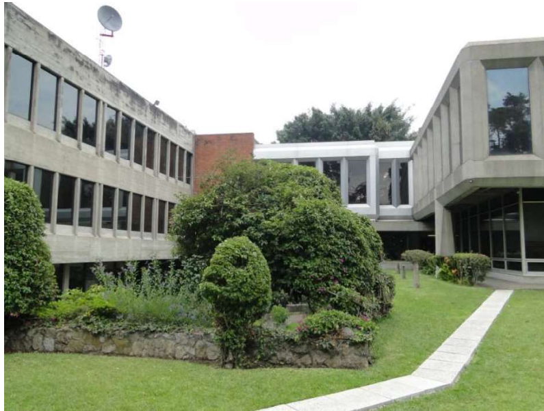
Figura 199. Edificio de producción, pasillo y administración, actual Agencias J. I Cohen (Anteriormente Laboratorios Abbott).
