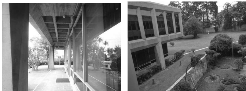
Figura 245. Concreto expuesto en edificios, y uso de piedra en muros de contención, Laboratorios Abbott (actual Agencias J. I. Cohen).
