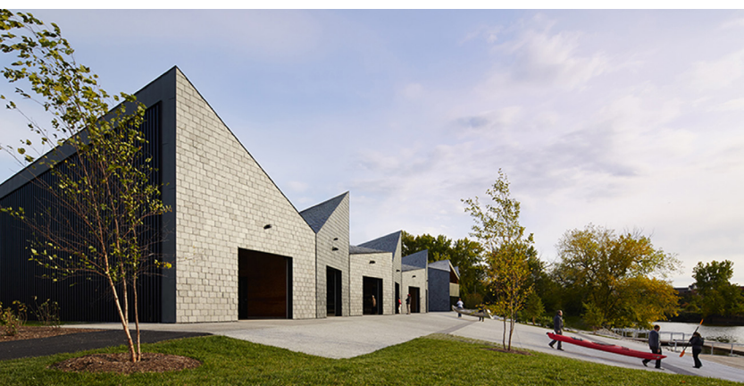
FOTOGRAFÍA NO. 39 - Análisis Material, Fuente Plataforma Arquitectura.
