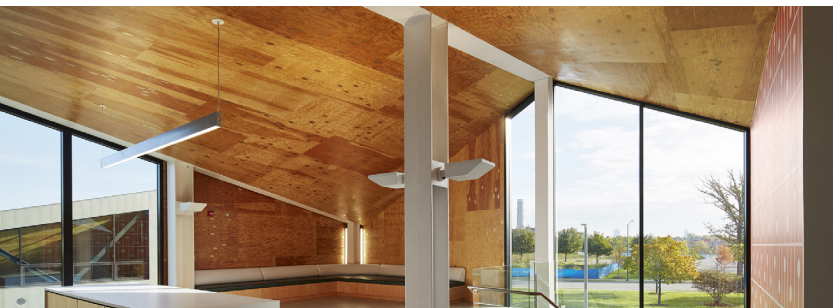
FOTOGRAFÍA NO. 37 - Análisis Estructural, Fuente Plataforma Arquitectura.
