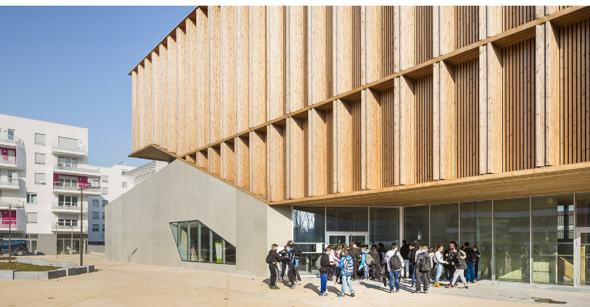
FOTOGRAFÍA NO. 33 - Análisis Material, Fuente Plataforma Arquitectura.
