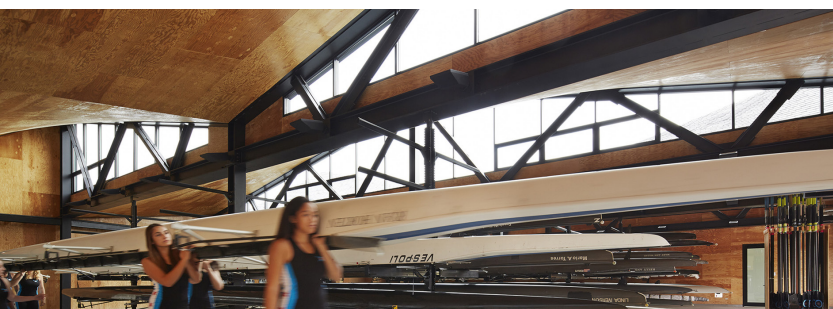
FOTOGRAFÍA NO. 38 - Análisis Estructural, Fuente Plataforma Arquitectura.
