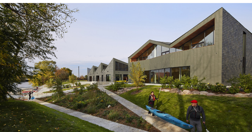
FOTOGRAFÍA NO. 40 - Análisis Material, Fuente Plataforma Arquitectura.
