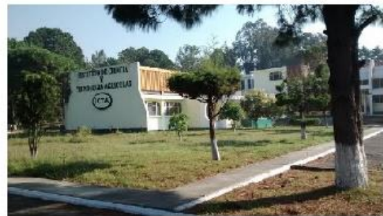
FOTOGRAFIA 2: Hace referencia al terreno colindante al este, Instalaciones del ICTA
