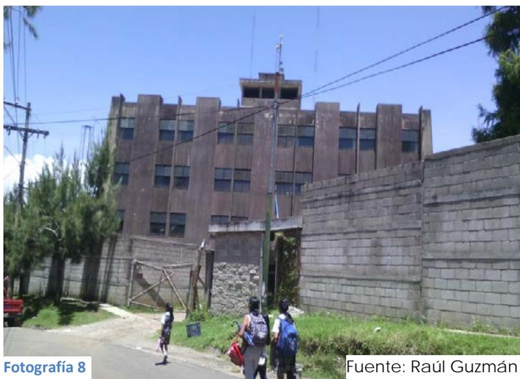
La construcción aledaña (Ex instalaciones de la radio TGW) cuenta con muro perimetral de mampostería, la construcción principal, hecha de concreto armado, resultando un edificio de cuatro niveles, de más de 10 años de existencia. El cual se utilizaba como
