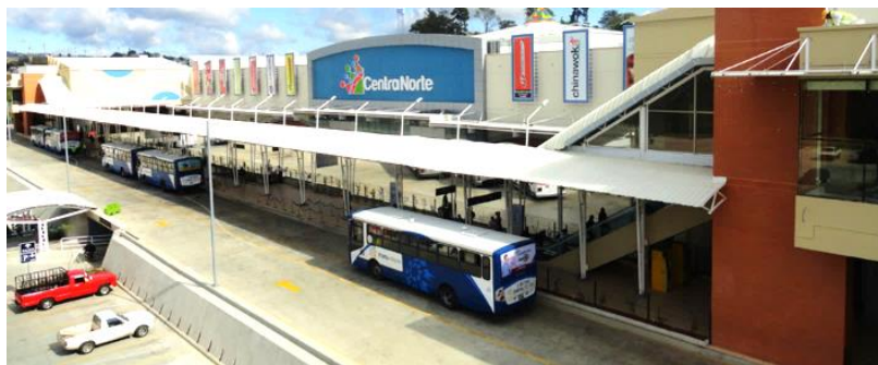
Fotografía no. 5 Centra Norte Guatemala andén de abordaje de rutas urbanas
