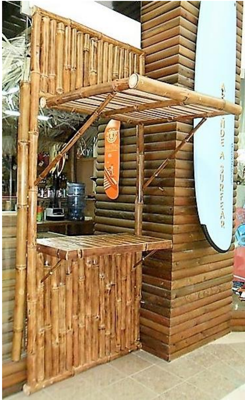
Imagen 43. Fachada de bambú, Guatemala. Fuente: Daniel Gálvez
