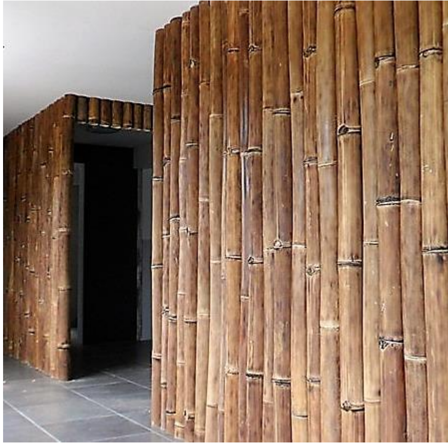
Imagen 1. Tabiques de bambú. Fraijanes, Guatemala. Fuente: Daniel Gálvez
