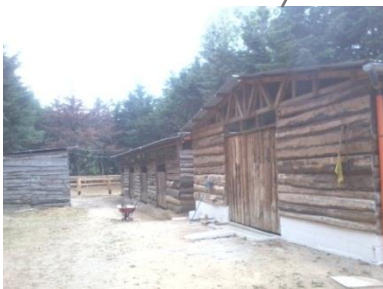
Fotografía 28: En la fotografía se muestra la vista hacia el módulo de conejos. Fotografía Propia.
