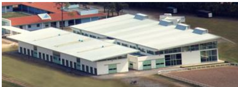
IMAGEN 33: AREA DE REHABILITACION
