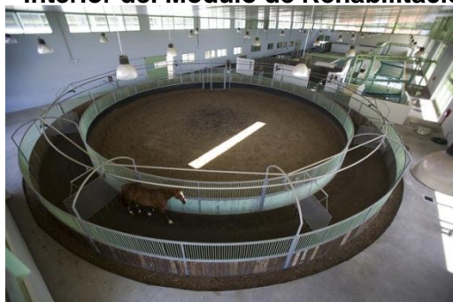
IMAGEN 35: INTERIOR MODULO DE REHABILITACION
