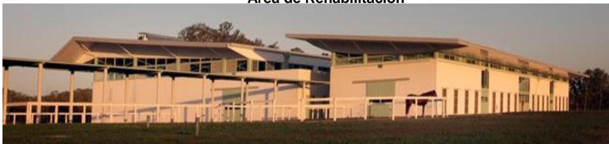
IMAGEN 32: AREA DE REHABILITACION
