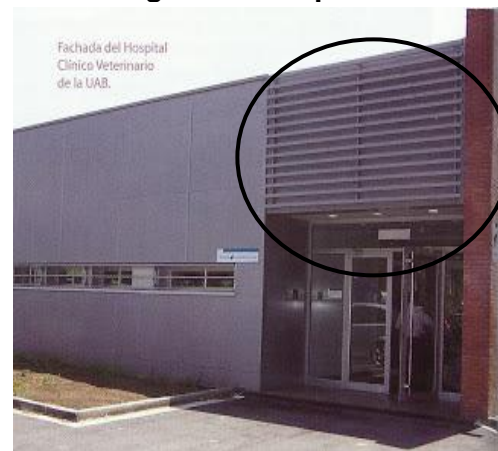
IMAGEN 20: INGRESO PRINCIPAL HOSPITAL CLINIC VETERINARI UAB
