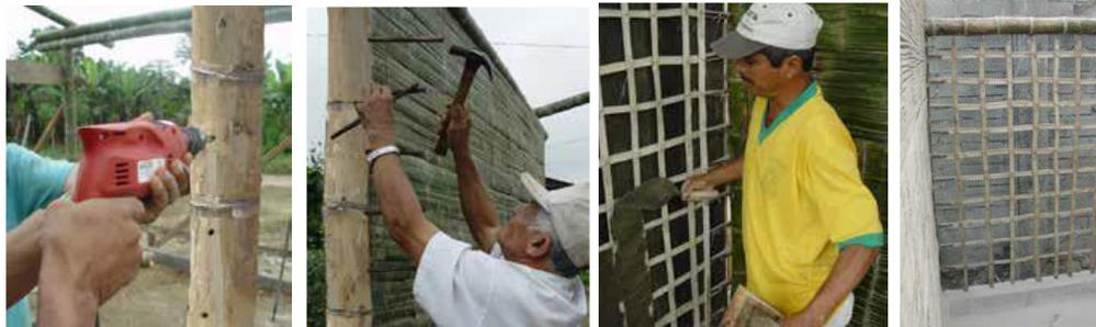
Figura 14 Muro tipo IPIRTI.
