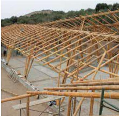
Figura 11 Colocación de correas.
