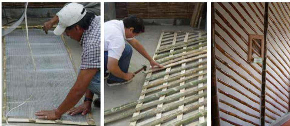
Figura 15 Muro tabique tipo panel romero.
