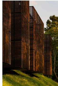
Todos los muros de fachada son de carpintería de metal con revestimiento de madera. Detrás del revestimiento, muchas aperturas al azar dan mucha luz natural en el interior, mientras que el revestimiento exterior proporciona una protección confortable del sol. Durante el día, esto crea un ambiente de calidad y en la noche, efectos de luz atractivos.
