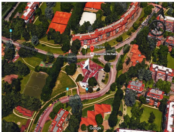
FOTOGRAFÍA 38: Vista aérea de la Parroquia FUENTE: Google Maps
