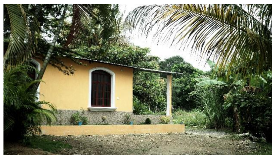
Imagen 6, Viviendas. Fuente: propia
