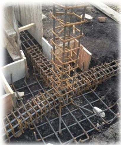
IMAGEN DE ARMADO DE ZAPATA Y VIGAS DE AMARRE COMO CIMENTACIÓN.
