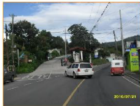
LAS CALLES PRINCIPALES CUENTAN CON BUENA SEÑALIZACIÓN CON PINTURA, SU ASFALTO ES DE MUY BUENA CALIDAD Y ALGUNAS CUENTA CON VEGETACION
