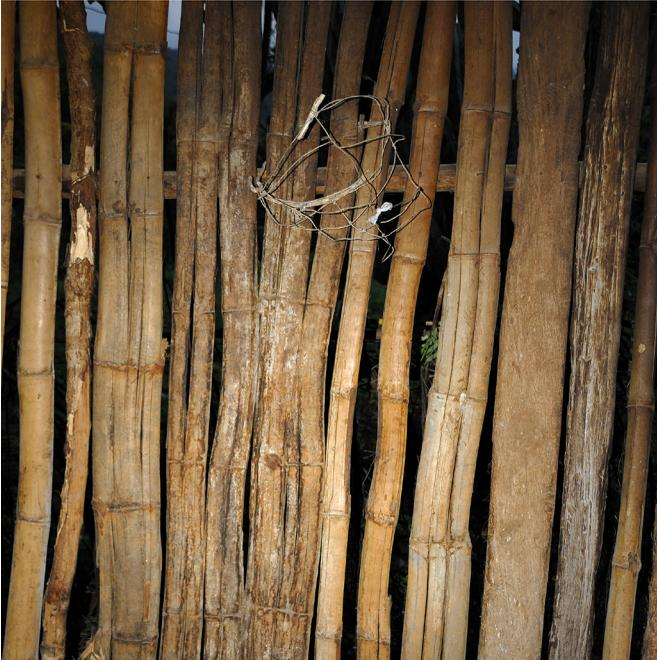
**10** Sustituir el bajareque por paredes de adobe y aplicando un repello consistente en 3 medidas de arena de río por 1 de suelo de la localidad.
