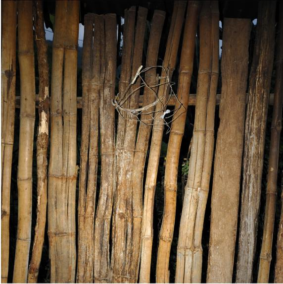
**10** Sustituir el bajareque por paredes de adobe o block y aplicando un repello con una mezcla de cal, arena de río, cal y sal.
