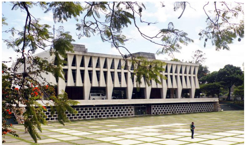
Figura 18. Edificio de Rectoría USAC. Por Juan Pablo Armas
