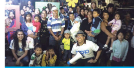
Vecinos de Santa Rita trabajando en la pavimentación de la entrada de acceso.
