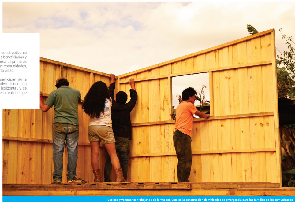
Vecinos y voluntarios trabajando de forma conjunta en la construcción de viviendas de emergencia para las familias de las comunidades
