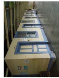
J) Perspectiva del corredor exterior de la administración hacia patios de secado.
