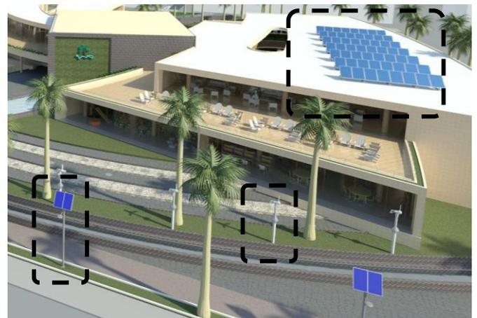
Utiliza fuentes renovables para **generación de energía**, por medio de **paneles fotovoltaicos** y **mini aerogeneradores**. Prioriza el uso de **sistemas pasivos** para el confort ambiental; como **iluminación a través de ventanas** y **tubos solares**, y **refrigeración a través de pozos provenzales**.
