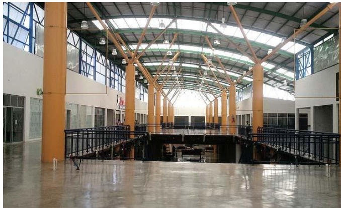
Figura No. 55 Fuente Sur http://todopormiguate.com
