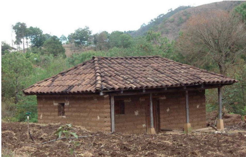
Imagen No 17, Vivienda Arquitectura Vernácula.
