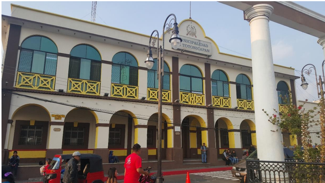
Imagen No 50 , Edificio Municipal de Totonicapán, ubicado sobre la 4ª. Calle. Fuente: Gramajo, José. Año: Marzo, 2016
