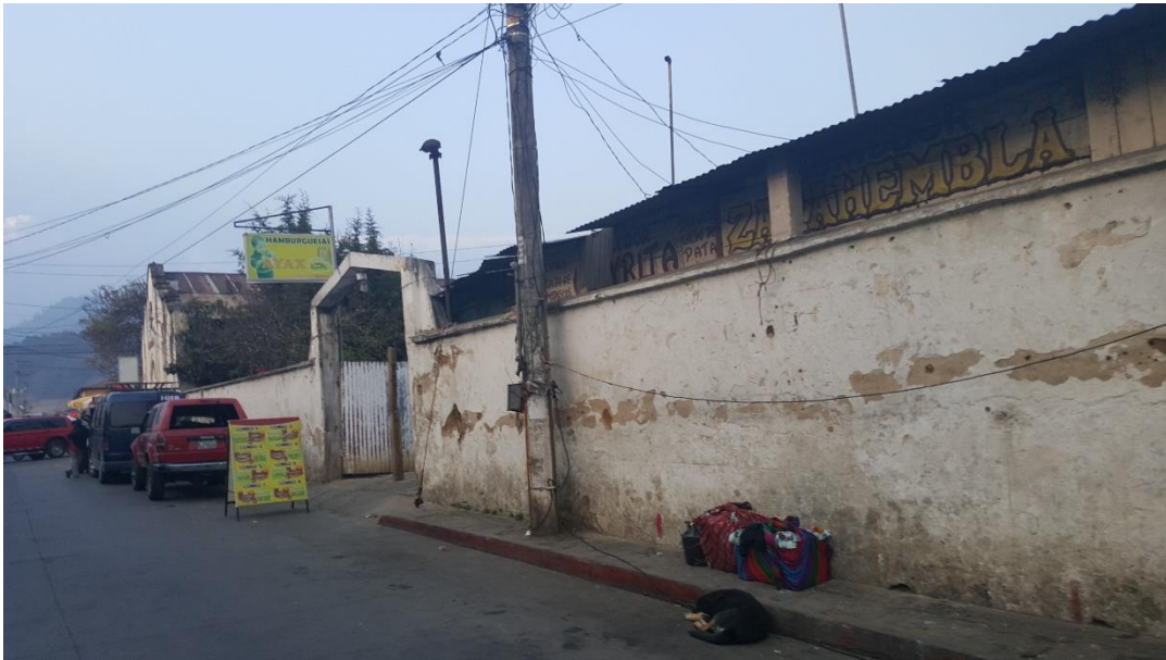
Imagen No 48 , Estado Actual de Infraestructura, sobre la 7ª. Avenida. Fuente: Gramajo, José. Año: Marzo, 2016
