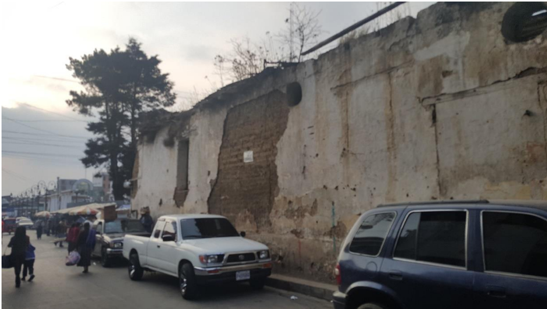
Imagen No 46, Estado Actual de Infraestructura, sobre la 5ª. Calle.
