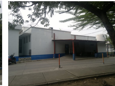
Foto 6 Ingreso Emergencias Pediatría
