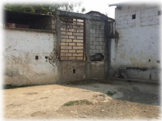
FIGURA 34 ÁREA DE DESCARGA "RASTRO MUNICIPAL DE SAN ANDRÉS ITZAPA, CHIMALTENANGO"
