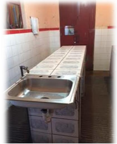
FIGURA 55 ÁREA DE INSPECCIÓN "RASTRO MUNICIPAL DE QUETZALTENANGO"
