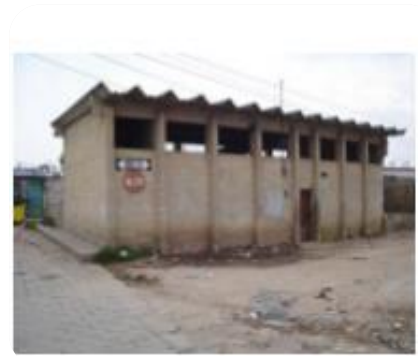
FIGURA 60 FACHADA PRINCIPAL DE RASTRO MUNICIPAL DE SALCAJÁ, QUETZALTENANGO"
