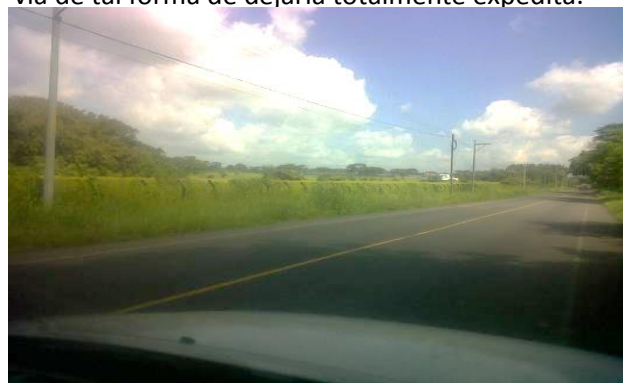
Gráfica 30 Vista acceso principal al terreno Km 68 CA-09. Fotografía propia.
