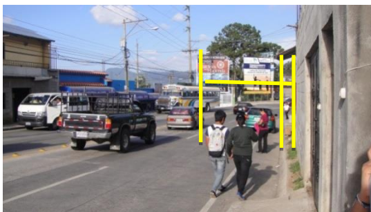
Fotografía No.6: Falta de acera Fuente: Elaboración Propia, septiembre 2014
