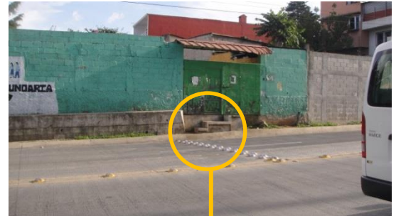
Fotografía No.5: Cambio de nivel Fuente: Elaboración Propia, septiembre 2014
