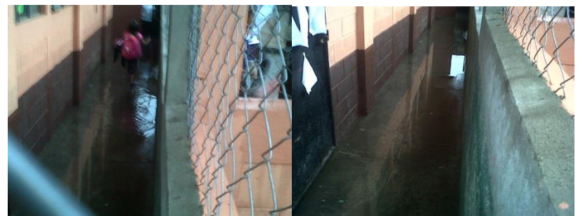
Fotografía No.7: Pasillos Inundados Fuente: Elaboración Propia, septiembre 2014
