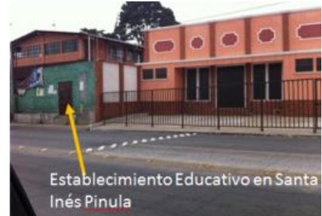
Fotografía No.22: Escuela + Salón Social Fuente: Elaboración propia, abril 2015
