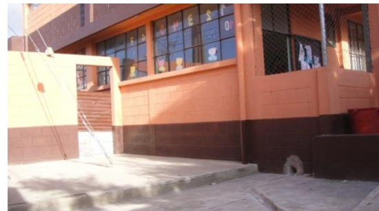
Fotografía No.9: Paso Obstruido
