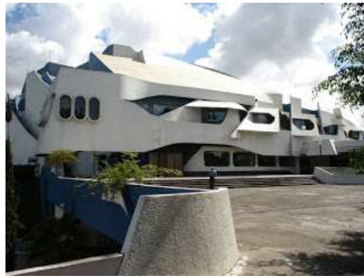
Foto 16: Vista de fachada frontal
