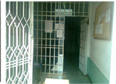
Foto 27: Ingreso por 3ra Avenida con Control de Ingreso.
