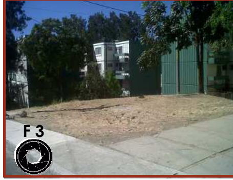
Foto 3: Edificios del módulo 08 en mal estado, con la imagen urbana deteriorada por falta de mantenimiento.
