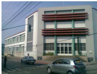
Foto 21: Ingreso y Tercera Avenida
