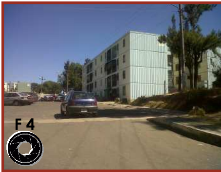
Foto 4: edificios del módulo 05 en mal estado, con la imagen urbana deteriorada por falta de mantenimiento.
