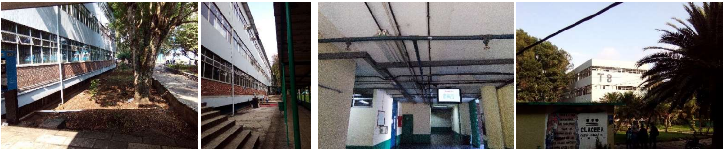
Fotografía 10 – Fotografías que muestran los aspectos Formales Arquitectónicos del Edificio T – 8 de la Facultad de Agronomía, USAC
