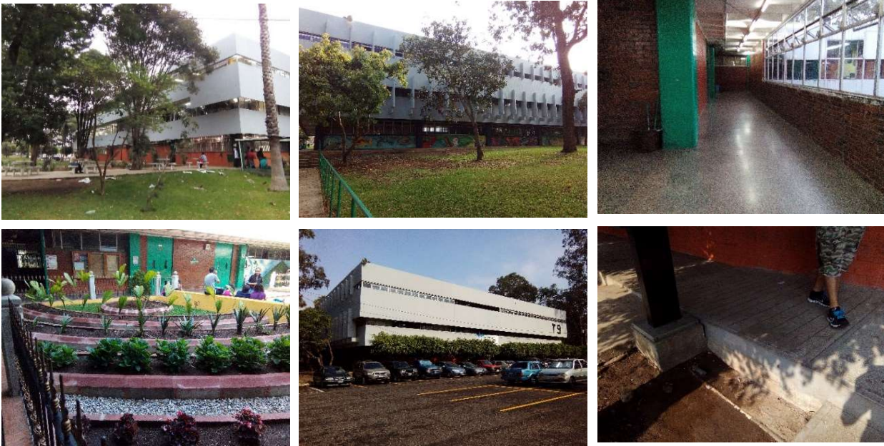
Fotografía 2 – Fotografías que muestran las características físico ambientales del edificio T-9, del Campus Central de la USAC
