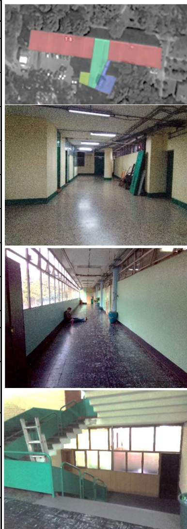
Fotografía 8 – Fotografías que muestran los aspectos funcionales del edificio T-8 de la Facultad de Agronomía, USAC
