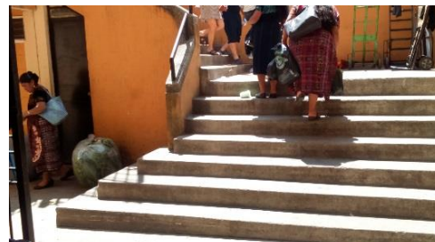
Los módulos de gradas son anchos lo cual facilita la circulación en el mercado
