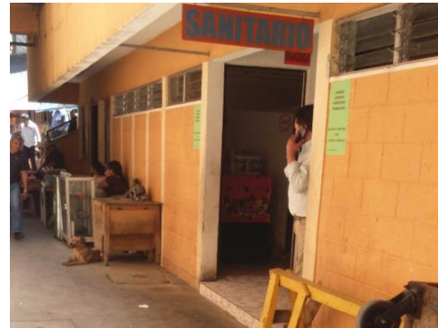
Los servicios sanitarios están ubicados en las dos plantas separadas para hombres como para mujeres.
