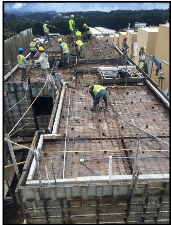
Vista de formaleta losa segundo nivel o losa final.
