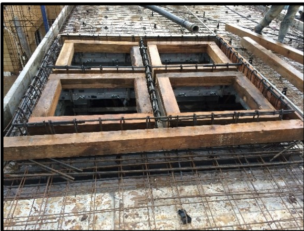
Formaleta de vigas en losa final.
