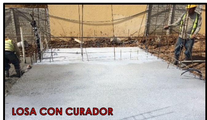
LOSA CON CURADOR Imagen No. 121 Autor: Cristian Juárez Proyecto: Bosques de Arrazola, 2016
