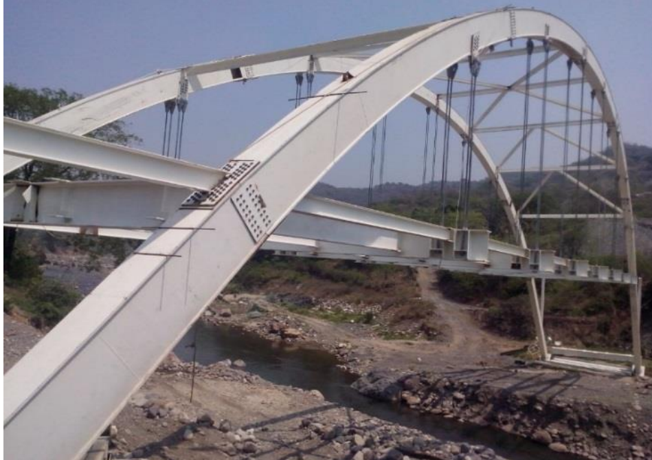
Fotografía: 6 Puente del río Concuá o Motagua, inconcluso desde el 2014 Fuente: Propia
