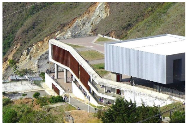
Imagen 39 Colegio Antonio Derka Diseño: Obranegra arquitectos, Medellín Antioquia, Colombia Fuente: http://www.plataformaarquitectura.cl/cl/627793/colegio-antonio-derka-santo-domingo-savio-obranegra-arquitectos
