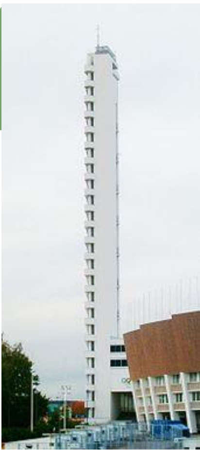
Imágen: 6 Fuente: 1 La torre del Estadio Olímpico de Helsinki (Y. Lindegren & T. Jäntti), construida en 1934-38. http://es.wikipedia.org/wiki/Funcionalismo_(arquitectura)
