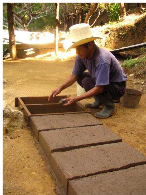
FIGURA 72 Fabricación de bloques para la construcción del Hotel Laguna Lodge
