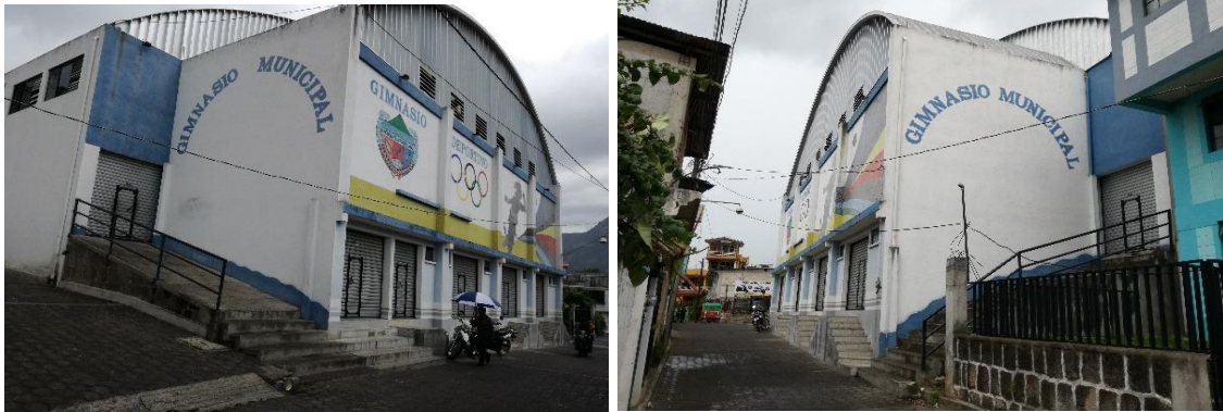
Ilustración 42. Vista exterior Gimnasio Municipal de San Pedro La Laguna. Fuente: fotografías propias.
