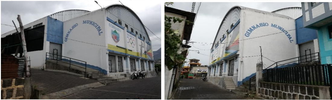
Ilustración 36. Vista exterior del Gimnasio Municipal de San Pedro La Laguna. Fuente: fotografías propias.
