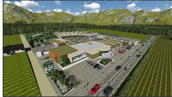
VISTA DESDE EL SUR-ESTE.
