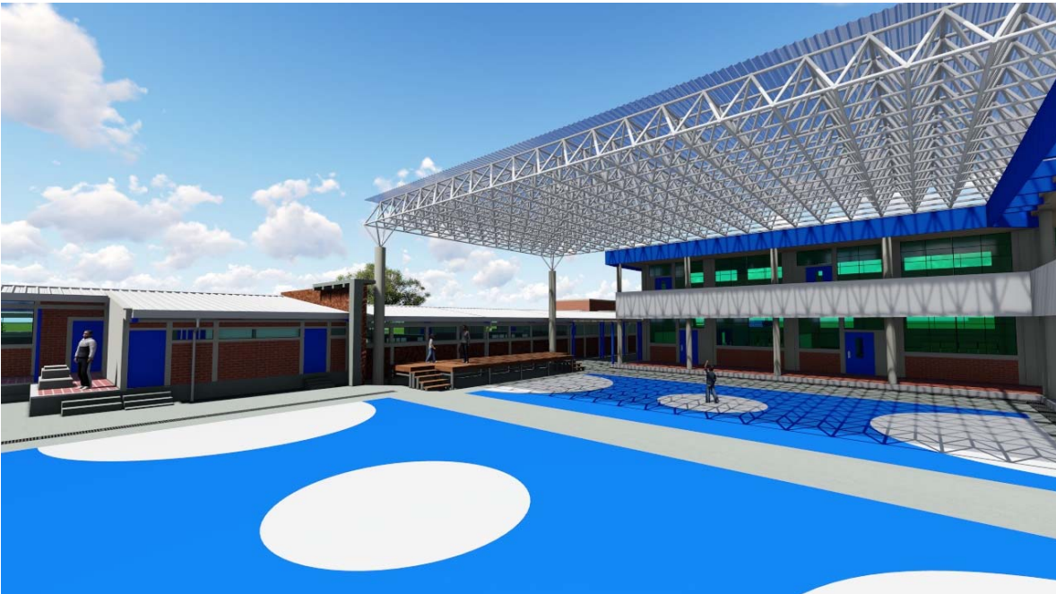
VISTA DE CANCHAS POLIDEPORTIVAS Y ESTEREOESTRUCTURA SOBRE UNA DE LAS CANCHAS.
