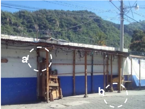
Fotografía No. 63 - Exterior de la “Escuela Central”, Avenida Santander
