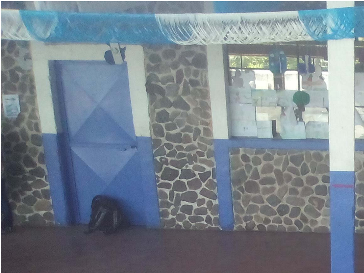
Fotografía No. 55 - Vista exterior de aula, Bloque “C”, Escuela Central.
