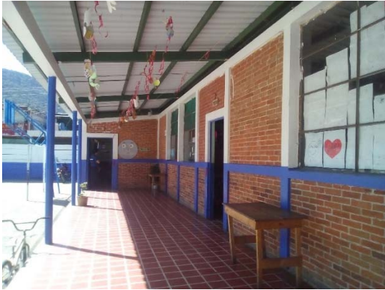
Fotografía No. 48 - Corredor Noreste, Bloque “A”, Escuela Central
