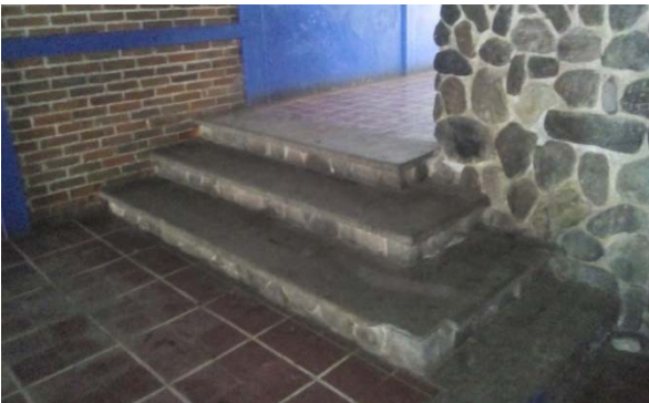
Fotografía No. 45 - Vista de gradas del Bloque A, Escuela Central.
