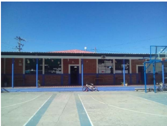
Fotografía No. 53 - Corredor Noreste, Bloque “A”, Escuela Central.
