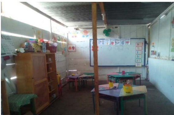
Fotografía No. 40 - Aulas provisionales de madera y lámina, Escuela Central.
