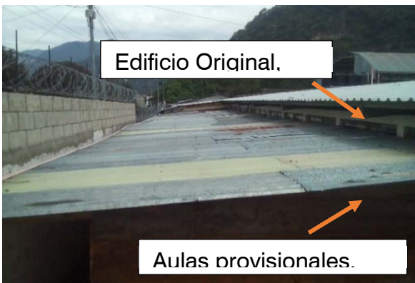
Fotografía No. 39 – Aulas provisionales y Edificio original, Escuela Central.
