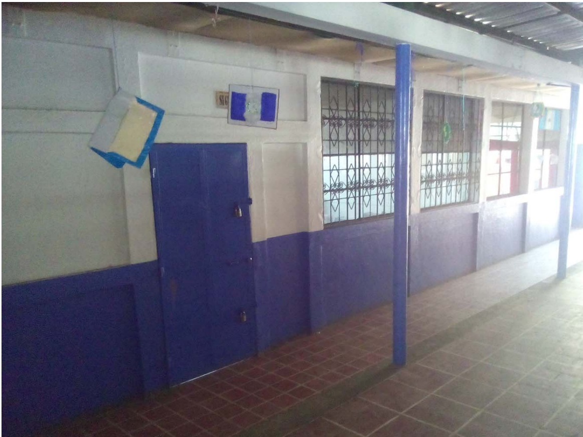
Fotografía No. 54 - Pasillo de acceso y salones, Bloque “B”, Escuela Central.
