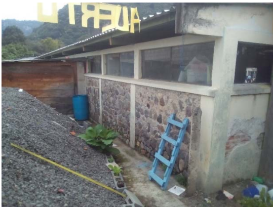
Fotografía No. 52 - Vista Sureste, Bloque “A”, Escuela Central.
