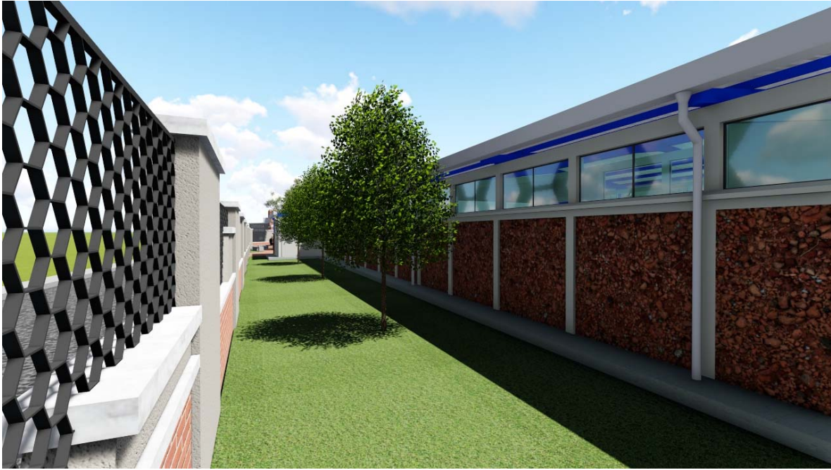
ÁREA VERDE RECUPERADA FRENTE A EDIFICIO ACTUAL (“BLOQUE A”) DE ESCUELA CENTRAL
