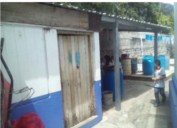
Fotografía No. 46 - Vista del área de bodegas, pilas y aula, Escuela Central.
