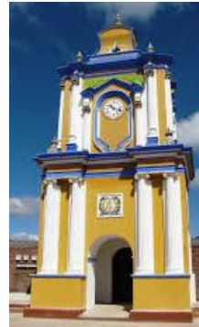
Ilustración 38. Fotografía Centenaria Torre Fuente: Tomada en campo por Celia Flores.
